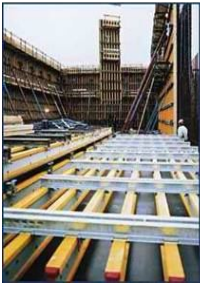
GF 20 опалубка больших площадей из балок H20
